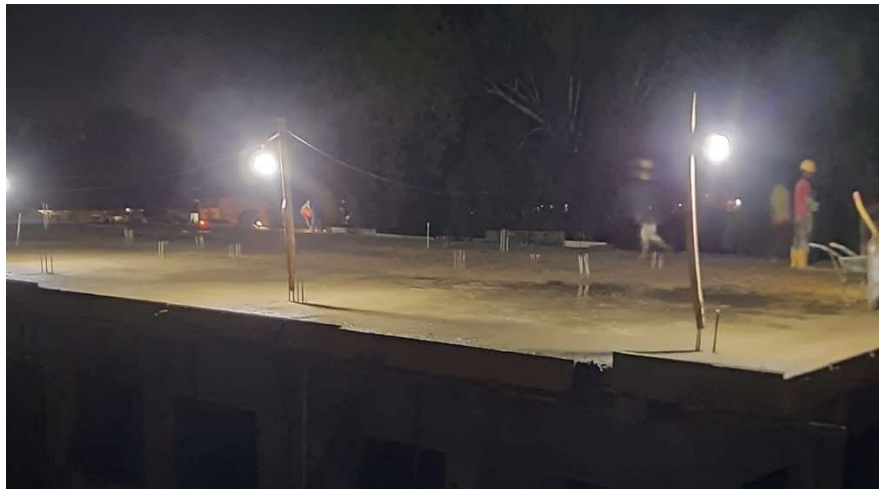
Er wordt tot laat in de avond doorgewerkt op het dak
