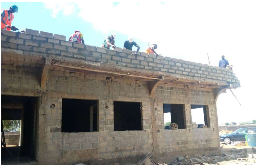
De laatste fase van de metselwerkzaamheden
