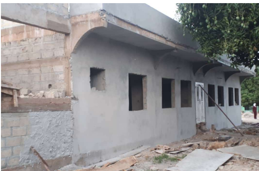
Het stucwerk aan de buitenkant vordert
