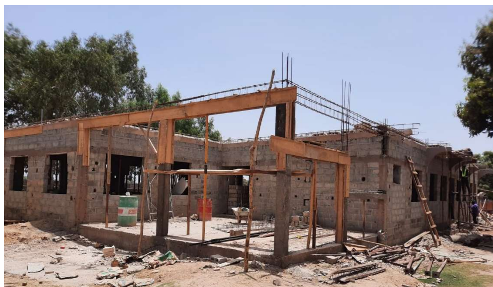
De voorkant van de nieuwe kraamkliniek in aanbouw
